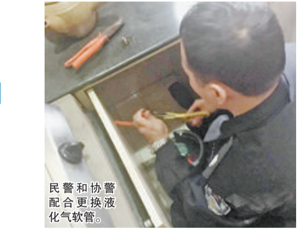
民警和辅警配合更换液化气软管。
