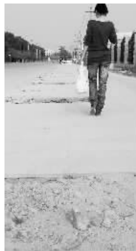
行道树被挖,留下一排坑。谢祯 摄
