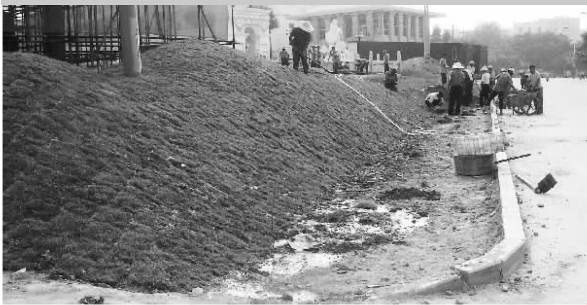
施工人员正在整改,留出一条人行道。谢祯 摄
