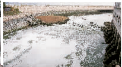
翁厝涵闸,污水滚滚排向大海。常海军 摄 P9B10037
