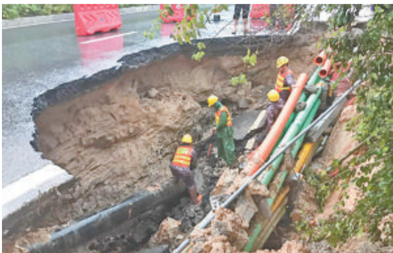
■水务工人正在抓紧抢修。
