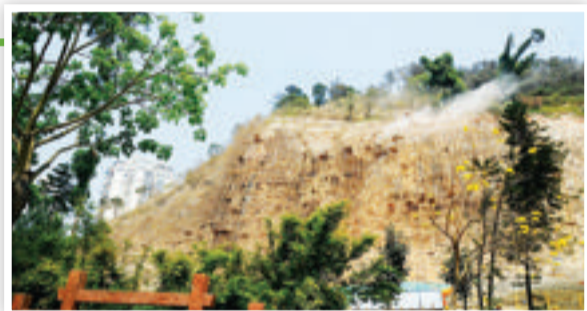
■施工中的 山体护坡
