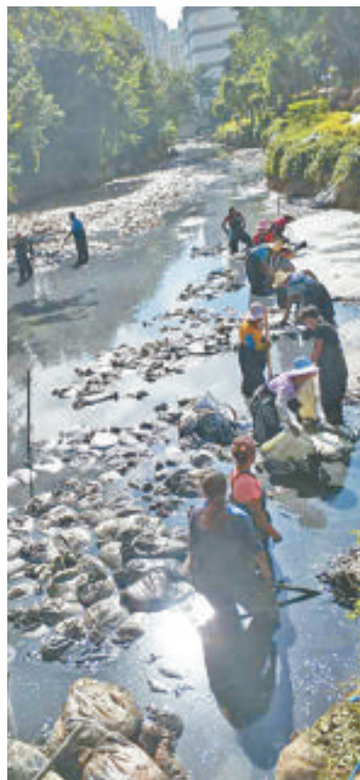
■工人在排洪沟清淤作业。
