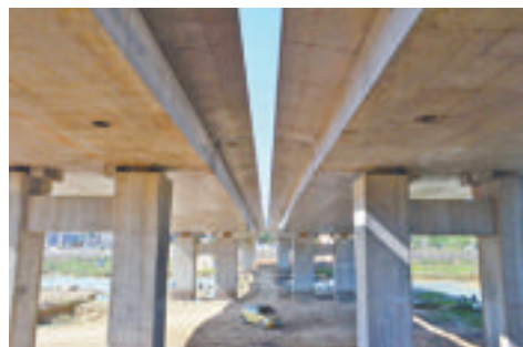
西溪特大桥。黄文水摄
